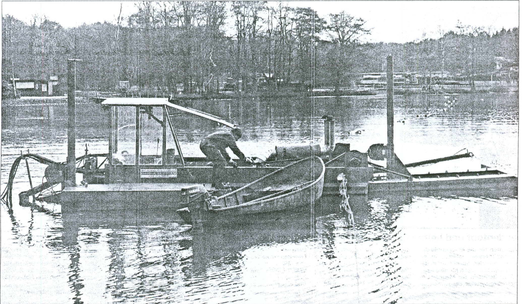
Rund 30000 Kubikmeter Schlamm werden aus dem Bootsteich gesaugt. Die Masse besteht vor allem aus faulendem Laub und ist laut Umweltschutzamt schadstofffrei.
