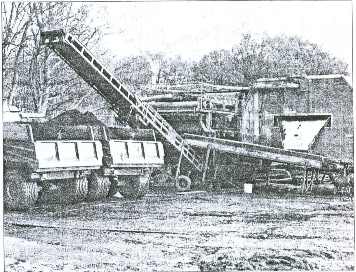
An Land wird das Baggergut ausgepresst und die Trockenmasse zu den Lagerflächen gefahren.
